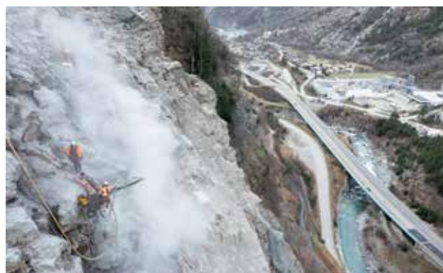
L'adaptation des infrastructures face aux conséquences du changement climatique sera au centre des échanges.
