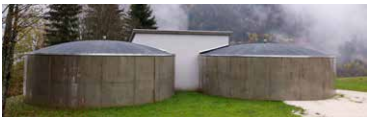
Le nouveau réservoir des Déserts
